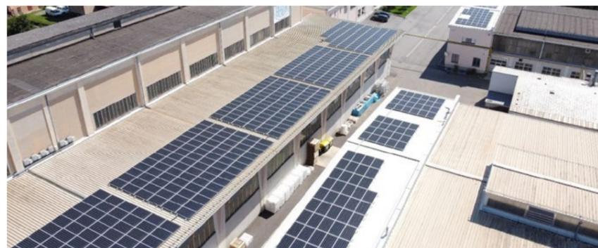
fotovoltaicas de la empresa Ökovolta Solartechnik GmbH. En total, se han instalado en los tejados de los edificios de oficinas y producción de la sede austriaca 961 módulos fotovoltaicos, lo que equivale a una superficie de 1634
